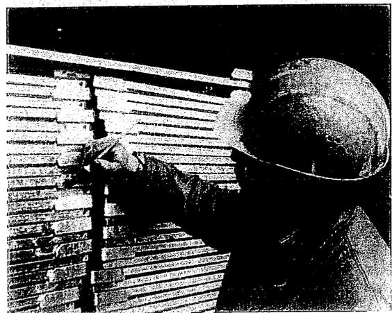
Abb. 2: Ausbessern von Schadstellen mittels Zinkstaub-Beschichtungsstoffen (Schadstellen nur kleinflächig ausbessern)
