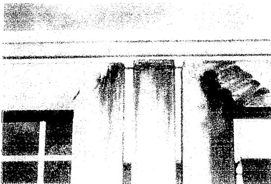
Abb. 4: Korrosion als Folge einer mangelhaft ausgebesserten Montageschweißung
