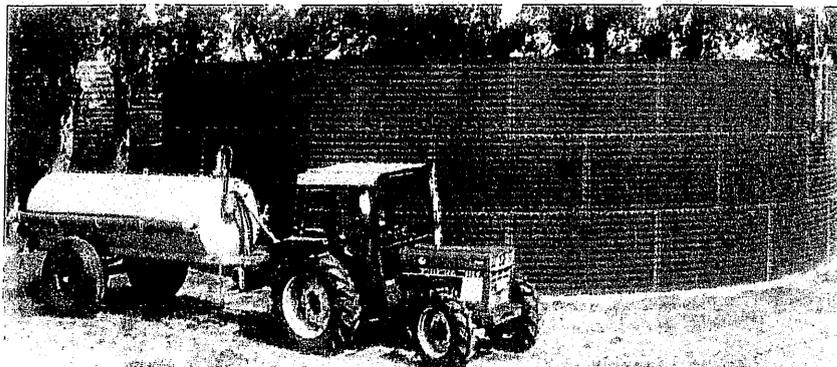
**Abb. 3: Güllesilo und Gülletankwagen in feuerverzinkter Ausführung (der Güllesilo ist zusätzlich beschichtet)**
