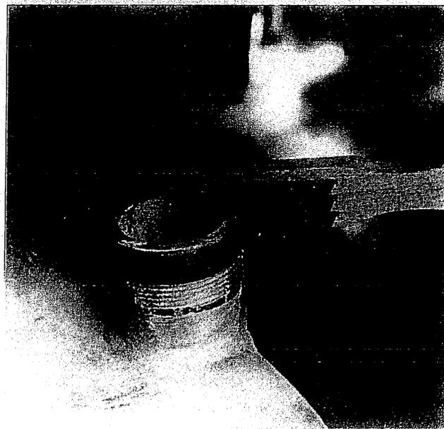
Abb. 2: Die Rückstände des Gewebebandes werden mittels Drahtbürste entfernt
