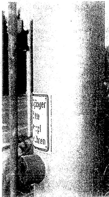
**Abb. 2:** Minimaler Weißrost an einem Signalmast; für die Wirksamkeit des Korrosionsschutzes ohne Bedeutung; bei zusätzlichen Beschichtungen muß jedoch auch diese geringe Weißrostbildung vor dem Auftragen der Beschichtung entfernt werden
