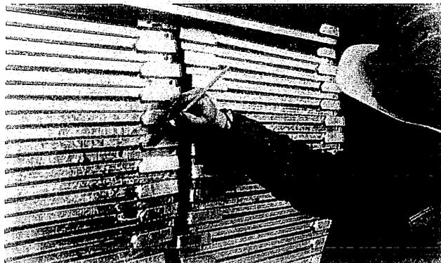
**Abb. 15: Ausbessern von Schadstellen durch Zinkstaub-Beschichtungsstoffe**
