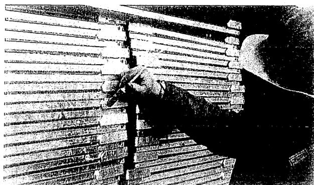
Abb. 4: Ausbessern der Feuerverzinkung mit Zinkstaubbeschichtungsstoff (Zinkstaubfarbe)
